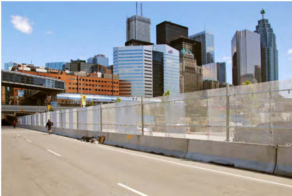
Photo 39 : 8 juin – La clôture de sécurité le long de la rue Lower Simcoe près du boulevard Bremner. (Photo prise par Tomasz Bugajski)
